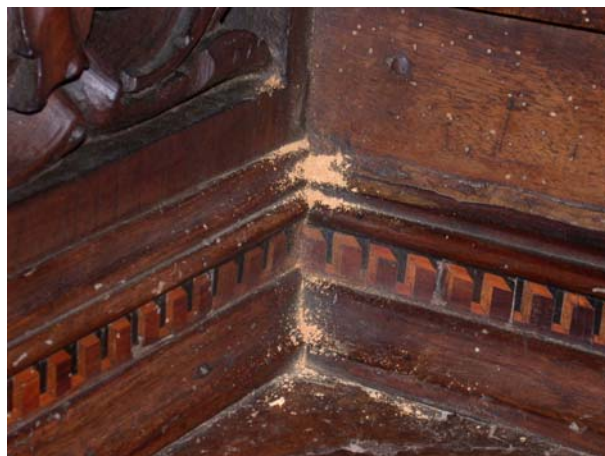
Fig.1. Attacco da insetti in atto su elementi di un coro ligneo
